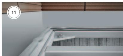
ÉTAPE 11: Appliquer du joint de polyuréthane sur les barres du cadre et poser le plateau dessus, en montant le siphon dessus. Monter la tuyauterie de vidange et placer le siphon.
