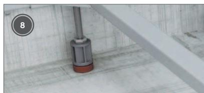
**ÉTAPE 8:** Positionner la structure et régler à la hauteur souhaitée, en respectant une mise à niveau parfaite.
