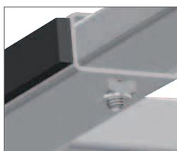
*Détail d'une des vis captives de fixation*
